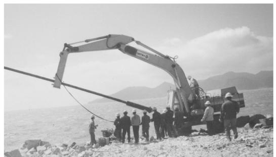
图 1 陆上装药机具外貌图
