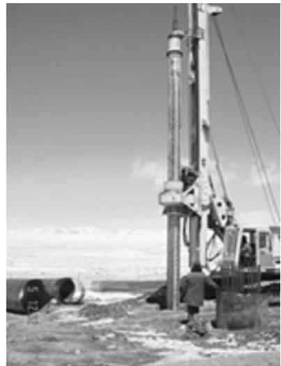
图 2 立塔动力头旋挖钻机
