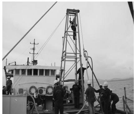
图2 海上水力反循环实时取样钻探施工场景
