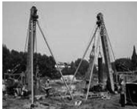
图2 冲击钻机成孔
