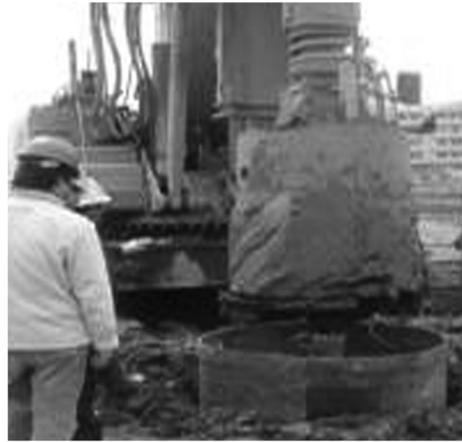
图1 旋挖钻机取土
