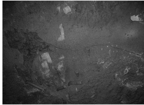
图5 支护开裂剥落
