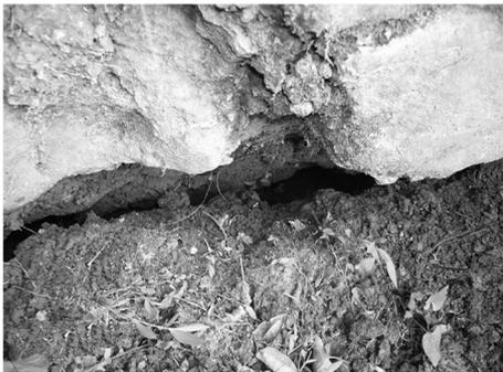
图3 隧道地表开裂
