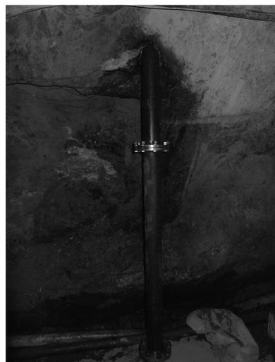
图4 坑道内套管安装效果
