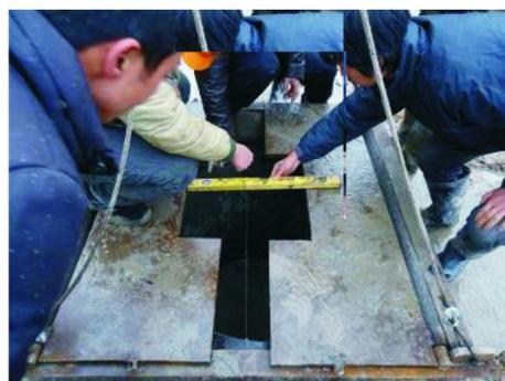
图 5 在定位架上测放柱位及方向并固定
