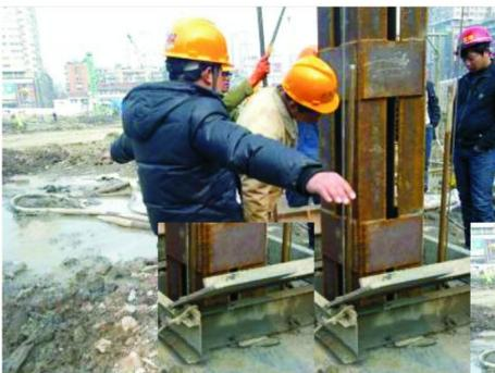
图7 钢格构柱与钢筋笼一起下置
