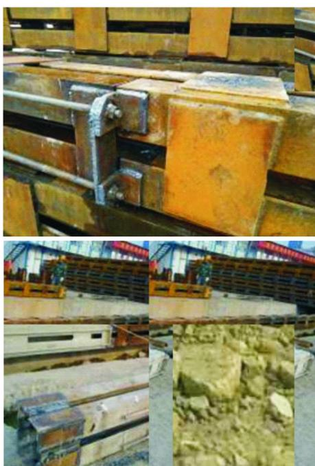
图 2 导向架与钢格构柱连接实物图
