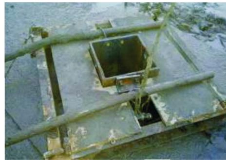
图8 用定位架卡住导向架定位
