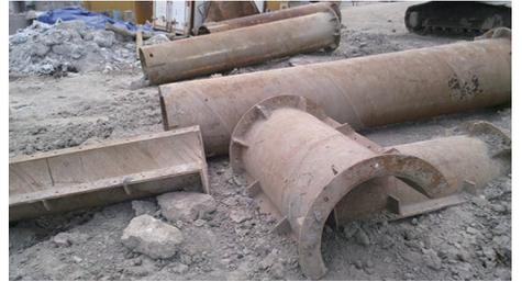
图 4 螺杆连接的导向节
