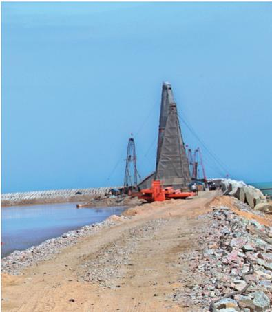
图2 筑岛式平台施工
