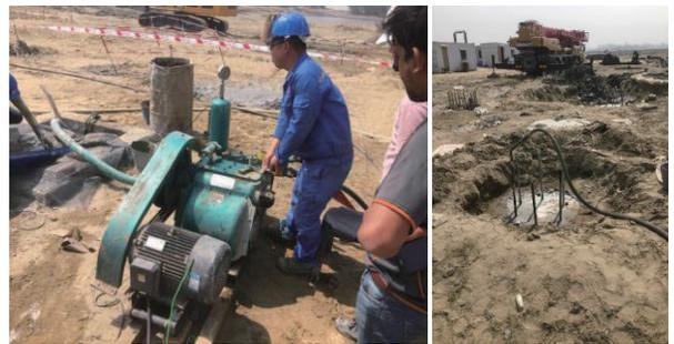
图 3 后压浆施工现场
