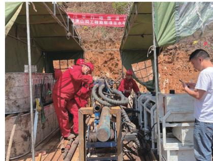
图 1 EP800 型水平钻机
