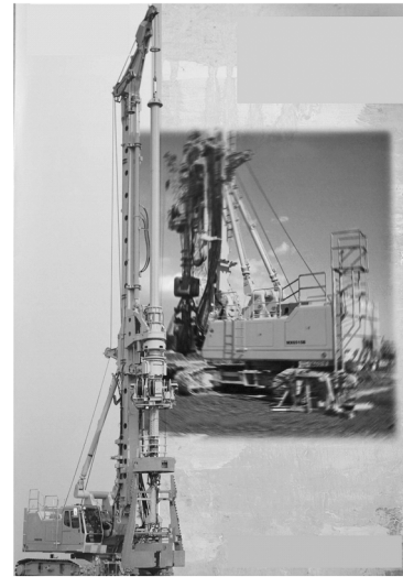
图4 配有液压回转接头和扩底钻头的立塔动力头旋挖钻机
