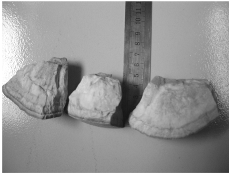
图2 出水口18天时的管壁胶结情况
