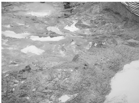
图1 开挖时产生的流砂
