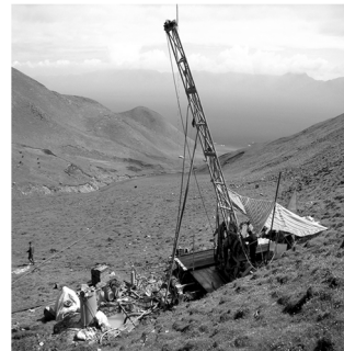
图1 青海某工地施工现场
