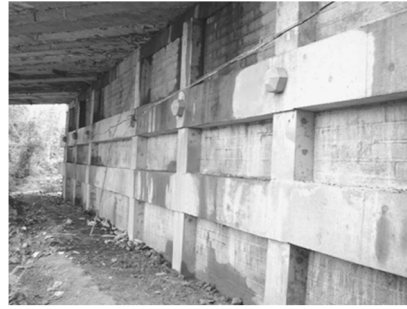
图 5 竣工后桥台前墙图
