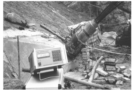
图3 锚索张拉现场测试照片
