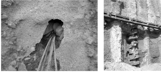
图1 完成的部分锚固孔
