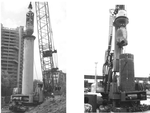
图 1 全套管冲抓成桩
