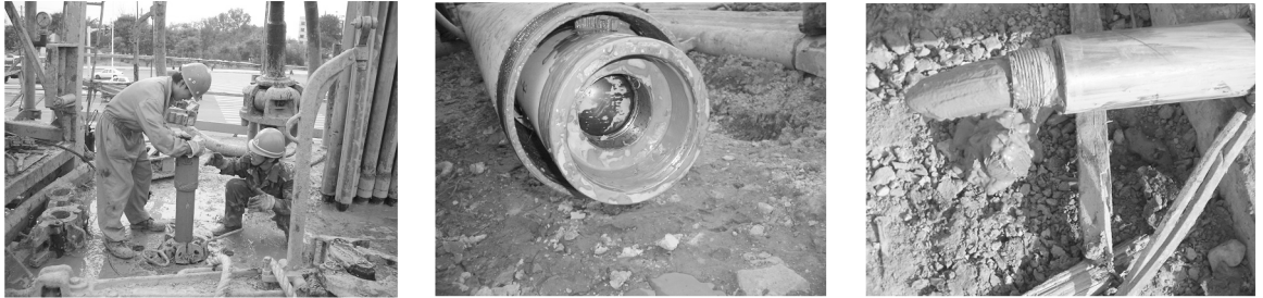
图 5 钻进取样试验施工现场及取出的样品
