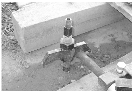
图 4 螺旋地茅对底座的固定
