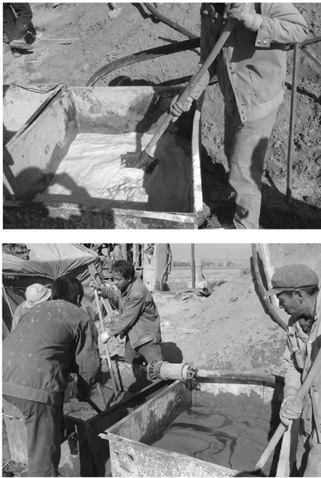
图2 止水材料搅拌现场
