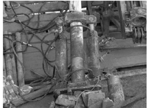
图 4 YBG60 型液压拔管机在云南小湾电站工地
