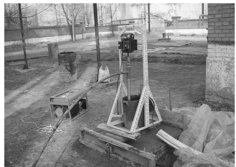
图 8 LW-28 型螺杆水泵抽水
