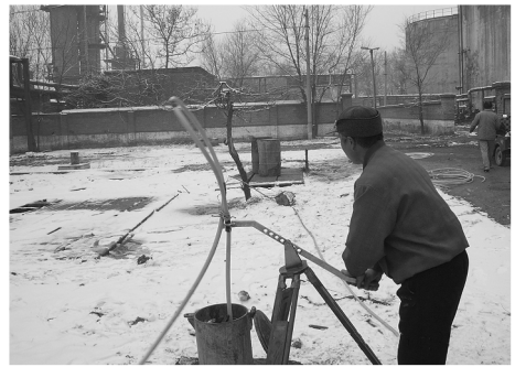
图 7 人工惯性泵洗井
