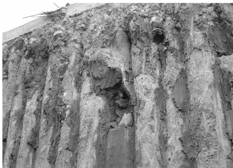
图 3 咬合桩夹泥现象照片
