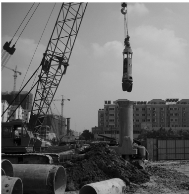
图3 咬合桩冲抓土施工现场
