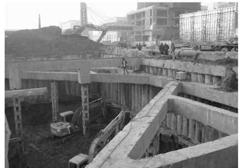
图 6 基坑开挖后的围护结构
