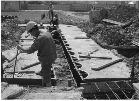
图2 咬合桩导墙的施工现场
