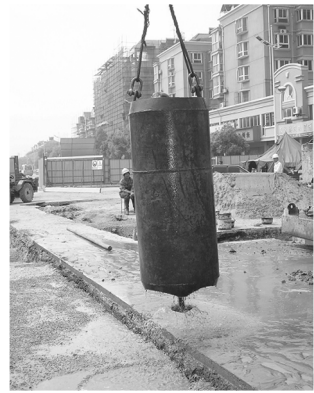
图 5 提水斗在承压水地层中提水施工作业
