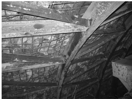
图 3 钢拱架的加固施工图
