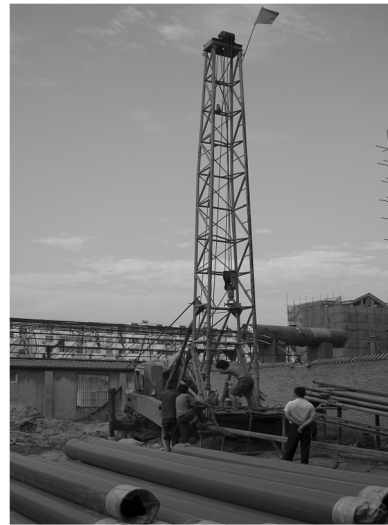
图4 437 m试验井成井现场
