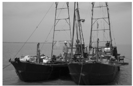
图2 双体船施工平台
