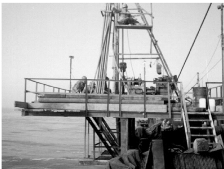
图1 单体船侧跨式施工平台
