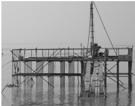
图 3 钢管支架施工平台
