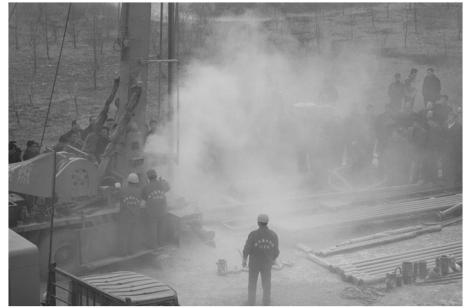
图6 正循环气动潜孔锤施工情况
