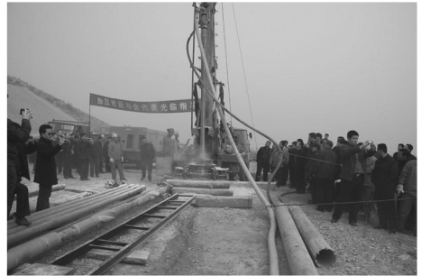
图7 反循环气动潜孔锤施工情况
