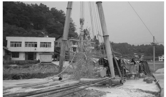
图4 正循环气动潜孔锤施工现场
