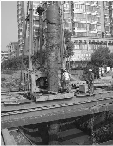
图 2 改装后的 GM-20 型拔桩钻机
