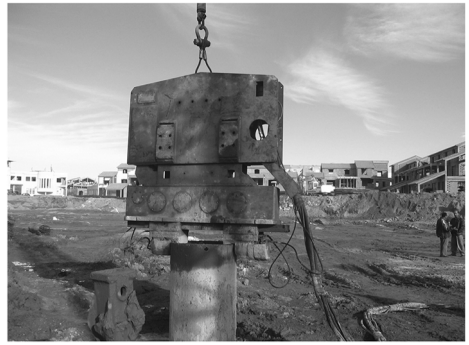
图2 振动锤施工现场
