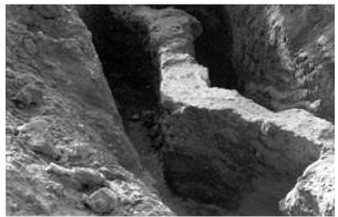
图2 砂砾石层中薄壁高压摆喷防渗墙体
