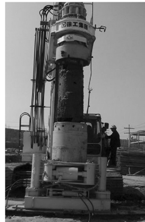
图 2 拔管机进行全套管施工现场
