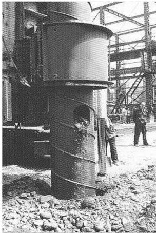
图 4 双动力头全套管钻进现场
