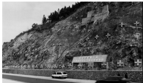
图 5 边坡加固效果
