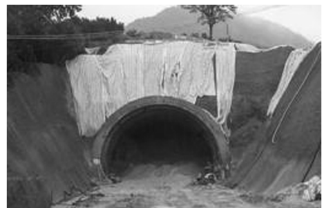
图 1 管棚法超前预支护进洞
