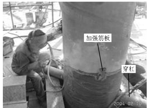
图4 去掉扶正箍完成套管的焊接状态
