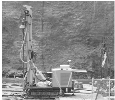
图 2 钻机施工现场
