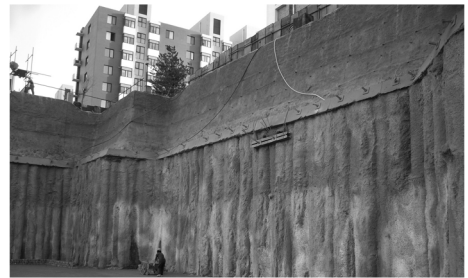
图3 开挖效果照片
