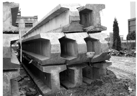
图6 预制混凝土接头
