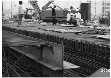
图4 止水钢板接头
