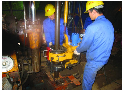
图 8 SQ114/8 型液压钳在江西九江武山施工现场
