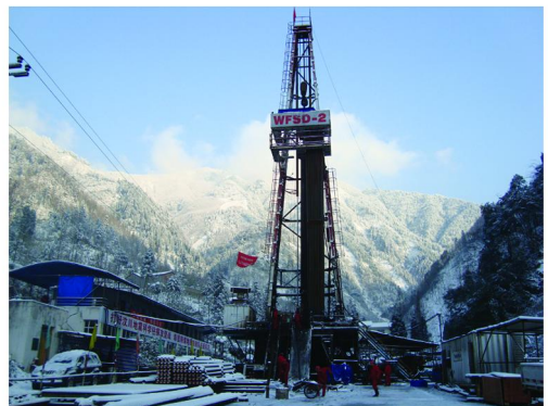
汶川地震断裂带科钻 2 号孔施工现场
