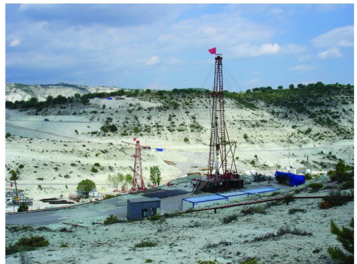
土耳其 Bepazari 采卤对接井工程施工现场
