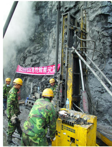
重庆武隆鸡尾山滑坡应急抢险施工现场
