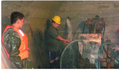
图6 渗流孔施工过程照片
