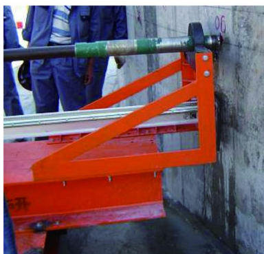
图 5 开孔导向定位器
