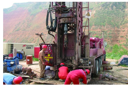
图 1 施工现场雪姆空气钻井配套设备
