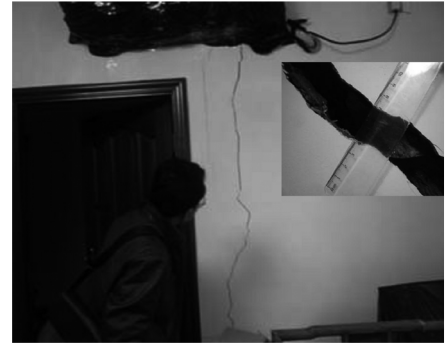
图 3 申康宾馆 4 号房内部开裂图
