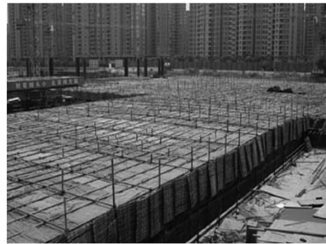
图 5 第一道支撑爆破防护棚外平面图
