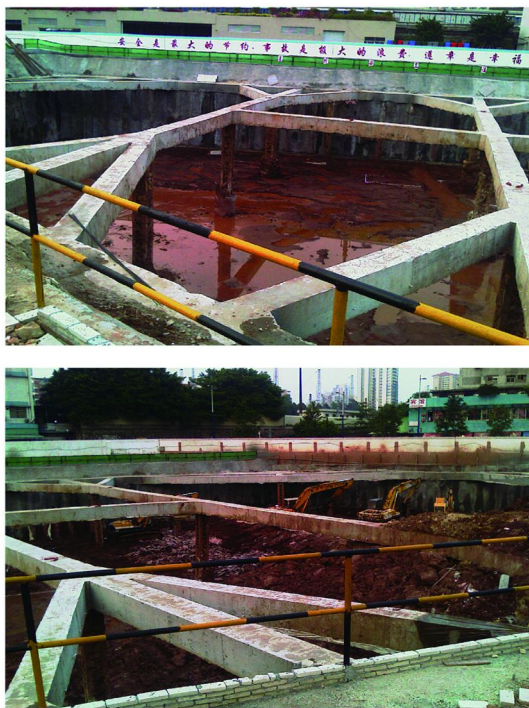
图6 基坑完成后实景图
