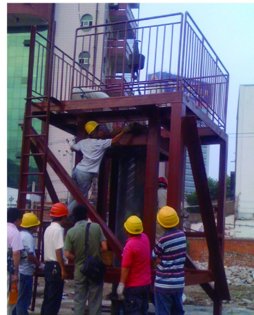
图4 施工人员正在调垂
