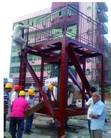
图5 对调垂后钢管进行固定
