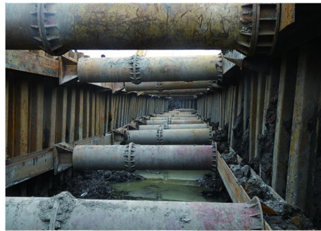
图6 支撑内部结构
