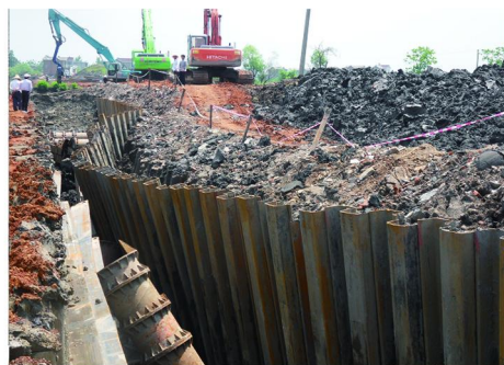
图4 钢板桩变形
