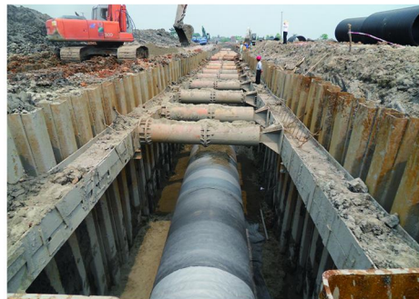
图5 铺管基坑实景
