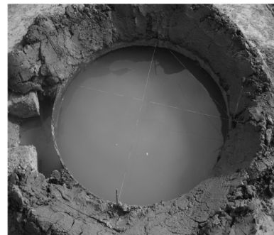
图1 埋设好的孔口护筒
